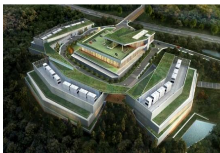
韓国 NHN Corp データセンター・研究所
